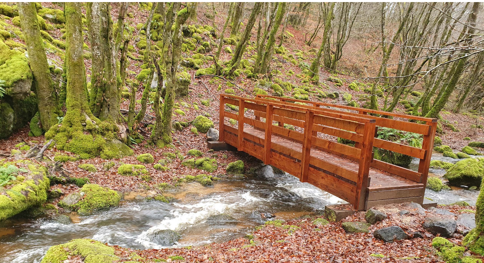
Au lac de Chaumeçon, l'un des 24 ouvrages de franchissement de zones humides réalisés en 2020
